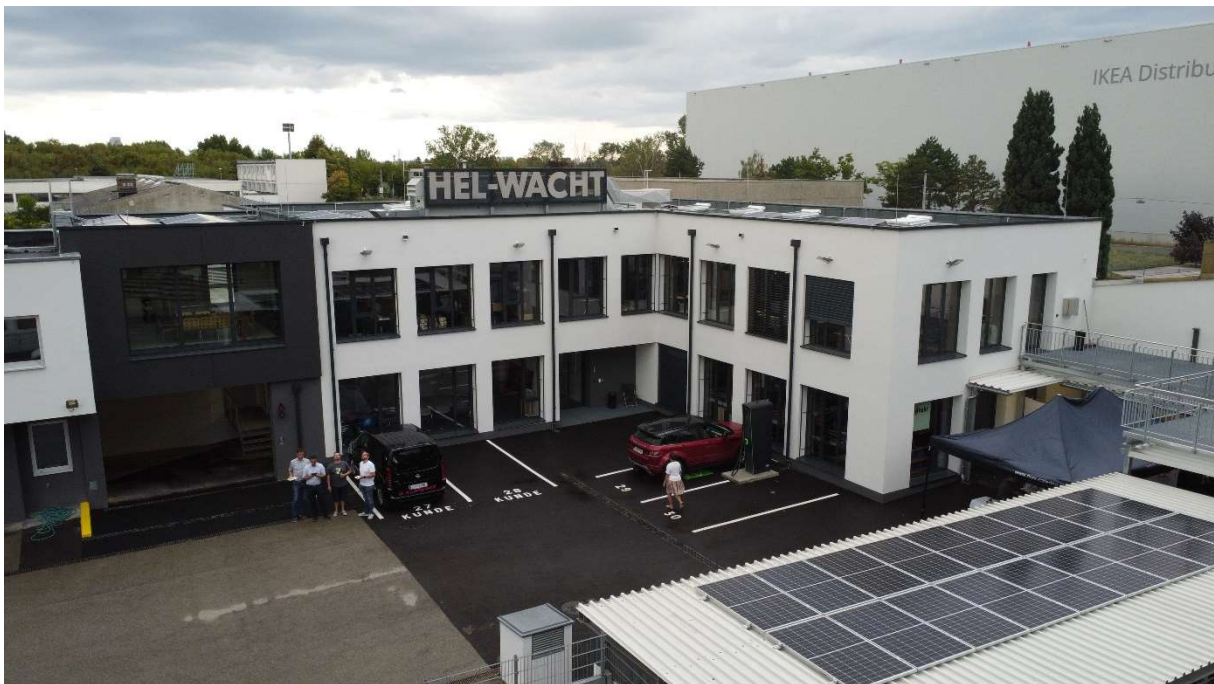
Abbildung 1: Zubau Scheydgasse 37, 1210 Wien - Headquarter der HEL-WACHT Gruppe
