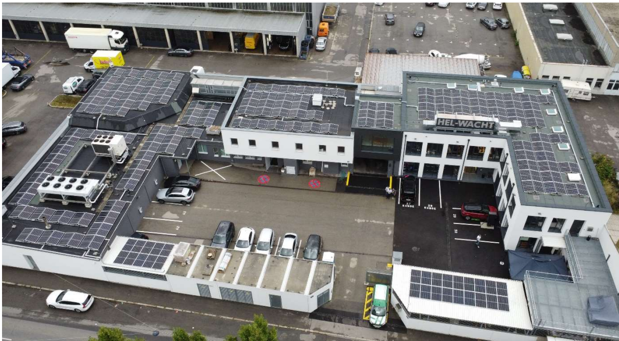
Abbildung 9: Photovoltaikanlage für energieeffiziente Bauweise
