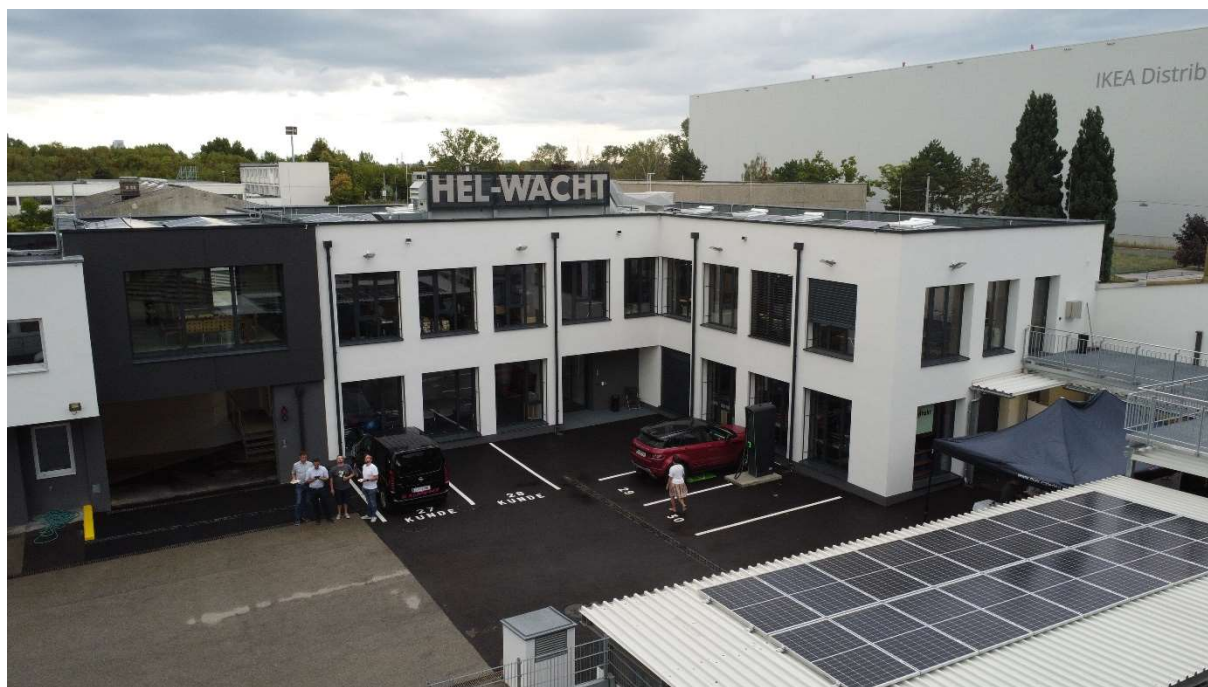
Abbildung 1: Zubau Scheydgasse 37, 1210 Wien - Headquarter der HEL-WACHT Gruppe
