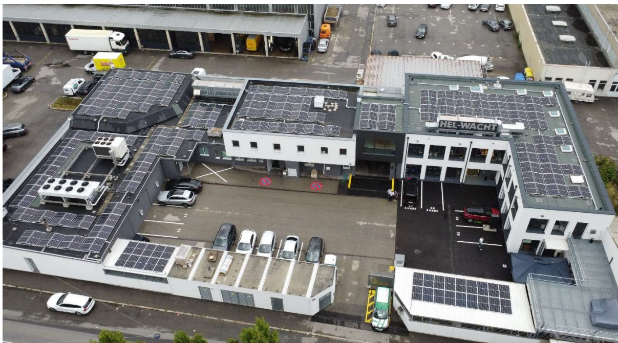
Abbildung 11: Photovoltaikanlage am Standort Scheydgasse
