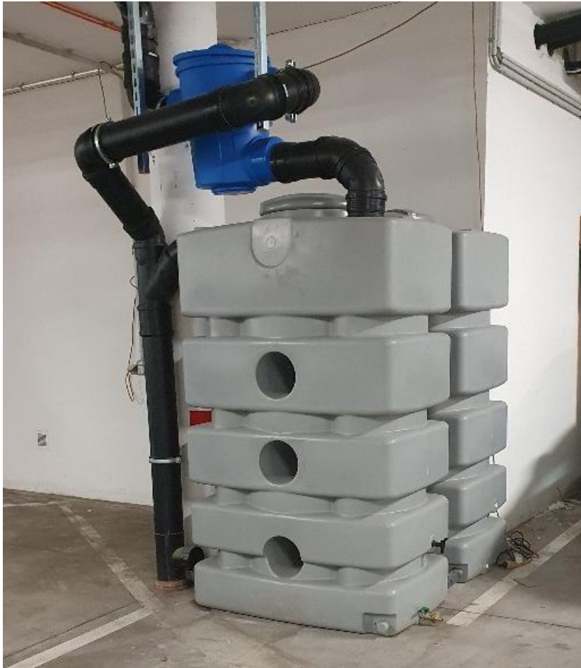
Abbildung 31: Brauchwassertank
