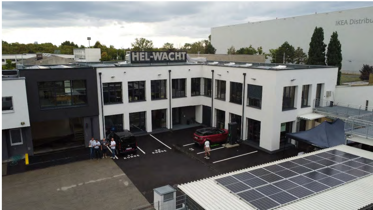
Abbildung 1: Zubau Scheydgasse 37, 1210 Wien - Headquarter der HEL-WACHT Gruppe
