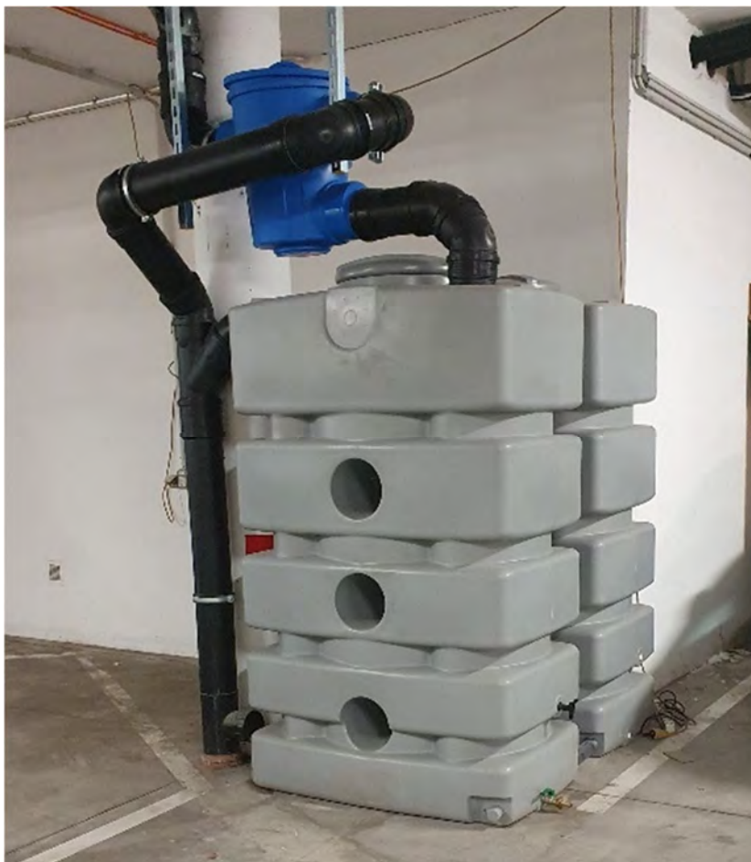
Abbildung 30: Brauchwassertank
